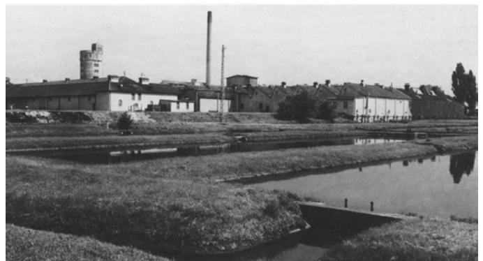
Die Vorklärbecken südlich des Werksgeländes im Jahr 1958.
